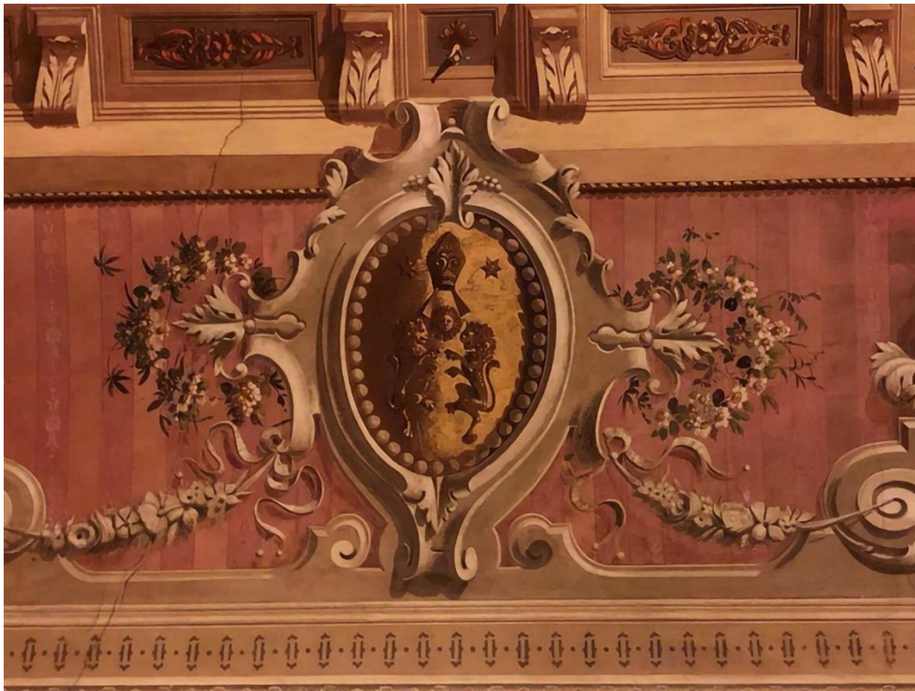
Figura 19. Stemma Del Prete, particolare della volta del Salone.
