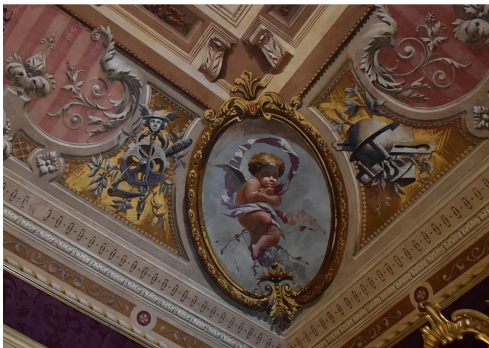
Figura 22. Inverno, particolare della volta del Salone.
