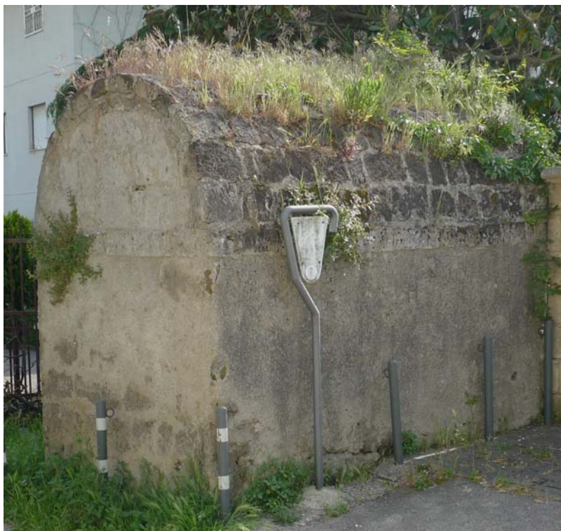
Figura 9. Il torrino del condotto delle 80 once, in prossimità della vigna e del casino del Fellaco.
