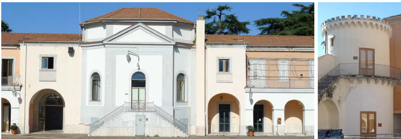
Figura 11. Vaccheria borbonica: facciata interna (a sinistra), la torre, forse già polveriera, 1851 circa (a destra) 142 .
