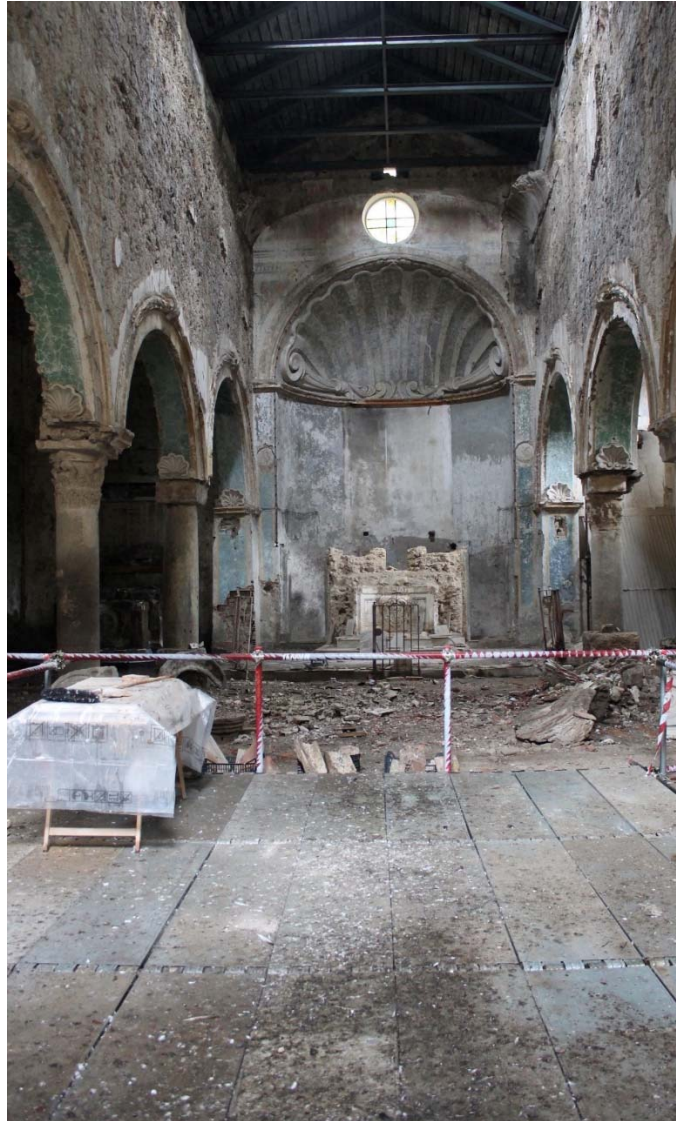
Figura 2. Maddaloni, chiesa di Sant’Agnello, interno navata centrale.
