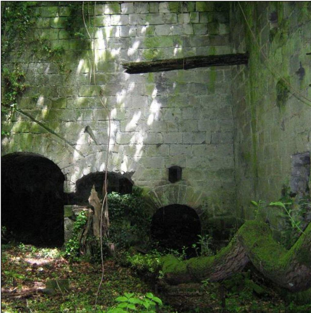
**Figura 6.** Camera di lavorazione della ramiera. A terra, in prossimità del tronco d'albero, si scorgono ancora i resti degli ancoraggi in ferro del maglio; sul fondo, le tre aperture arcuate dietro le quali era alloggiata la ruota idraulica.
