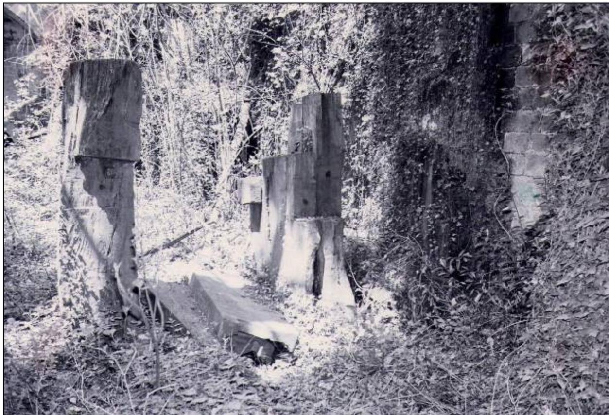
**Figura 13.** Supporti dei due magli nella camera di lavorazione della ferriera.
