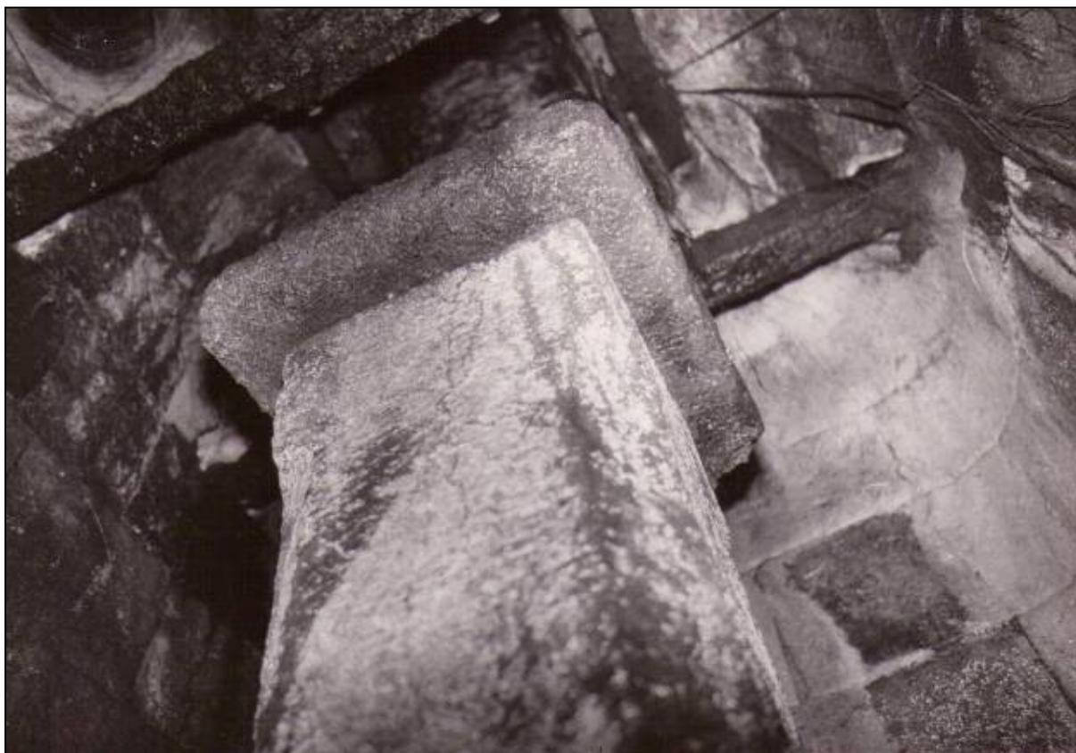
**Figura 27.** Particolare di una camera del vento con, in primo piano, il masso su cui veniva fatto cadere il flusso idrico.
