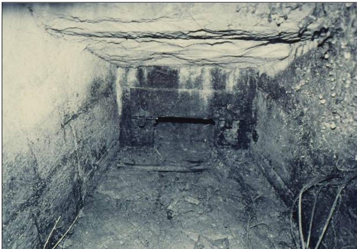
**Figura 32.** Condotto di scarico dell'acqua utilizzata nella camera del vento.
