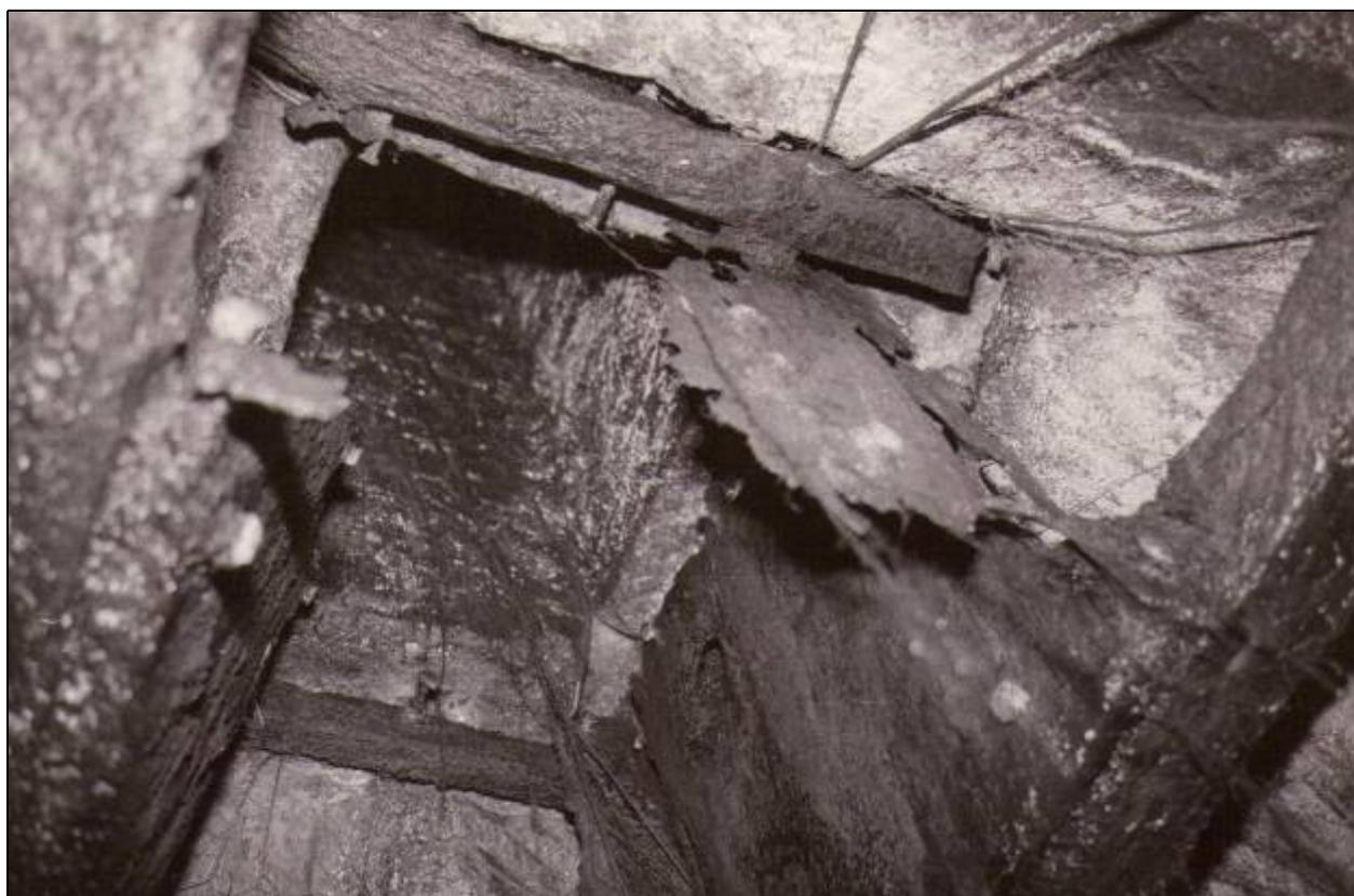
**Figura 30.** Condotto che conduceva l'acqua nella camera del vento.
