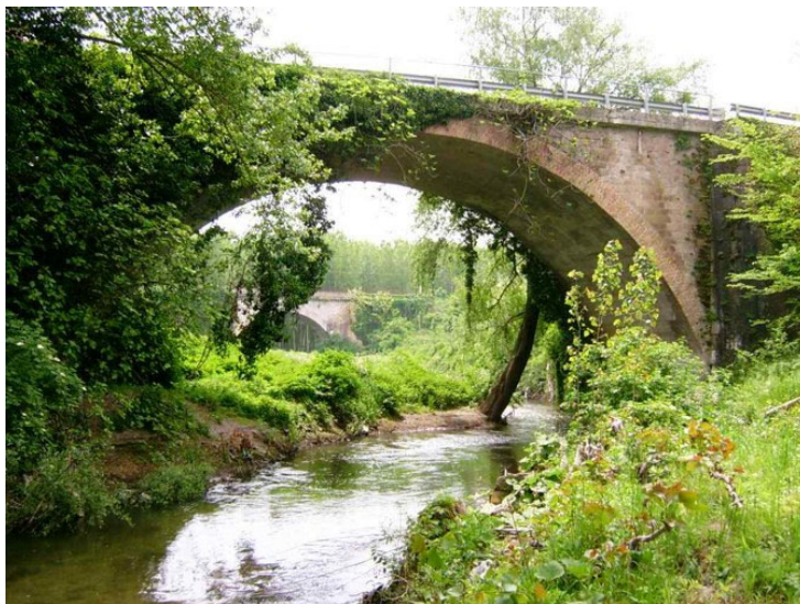
Figura 9. Ponte sul Biferchia
